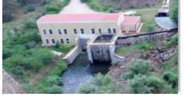
ÇAYGÖREN HES 4,60 MW
